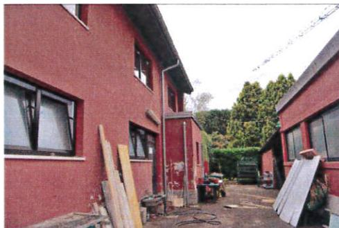
Edificato nel 1988, risulta realizzato con struttura portante in c.a. gettato in opera ed ha tamponamenti laterocementizi rifiniti ad intonaco tinteggiato con copertura a doppia falda inclinata con manto di rivestimento in tegole marsigliesi.
