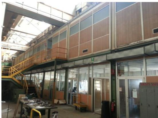
Lo stesso, la cui edificazione è avvenuta nel 1981, presenta un più che sufficiente stato conservativo ed ha struttura metallica, copertura a sheds con pannelli di alluminio coibentati e prospetti rivestiti in pannelli metallici sagomati.
